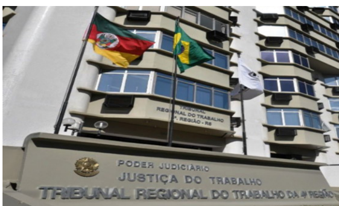
Prédio do TRT4, em Porto Alegre, que está fazendo a mediação na negociação
